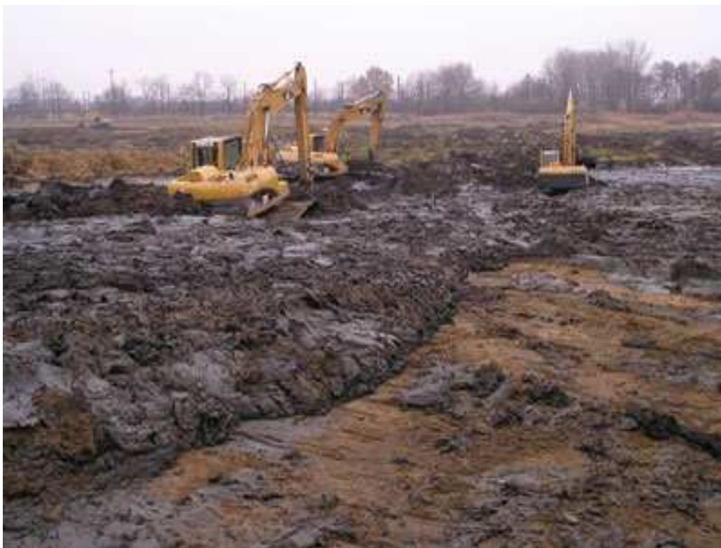
Obr. č. 4 Odbahnění Počernického rybníka v Praze ( www.casopisstavebnictvi.cz ).
