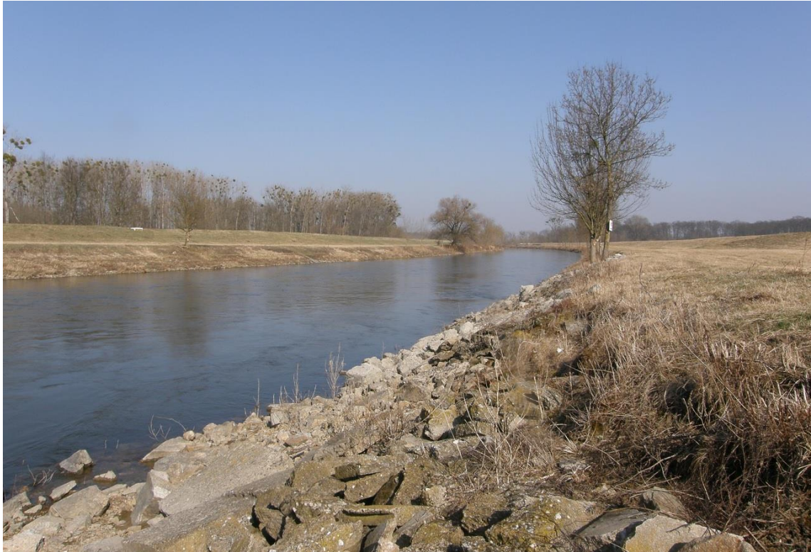
Obr. č. 10: Úsek řeky Dyje za bulharským jezem (foto autor). Koryto zde bylo odříznuto od svých meandrů, po celé délce má stejnou šířku, hloubku i spád. Hráze oddělily koryto od jeho záplavového území.
