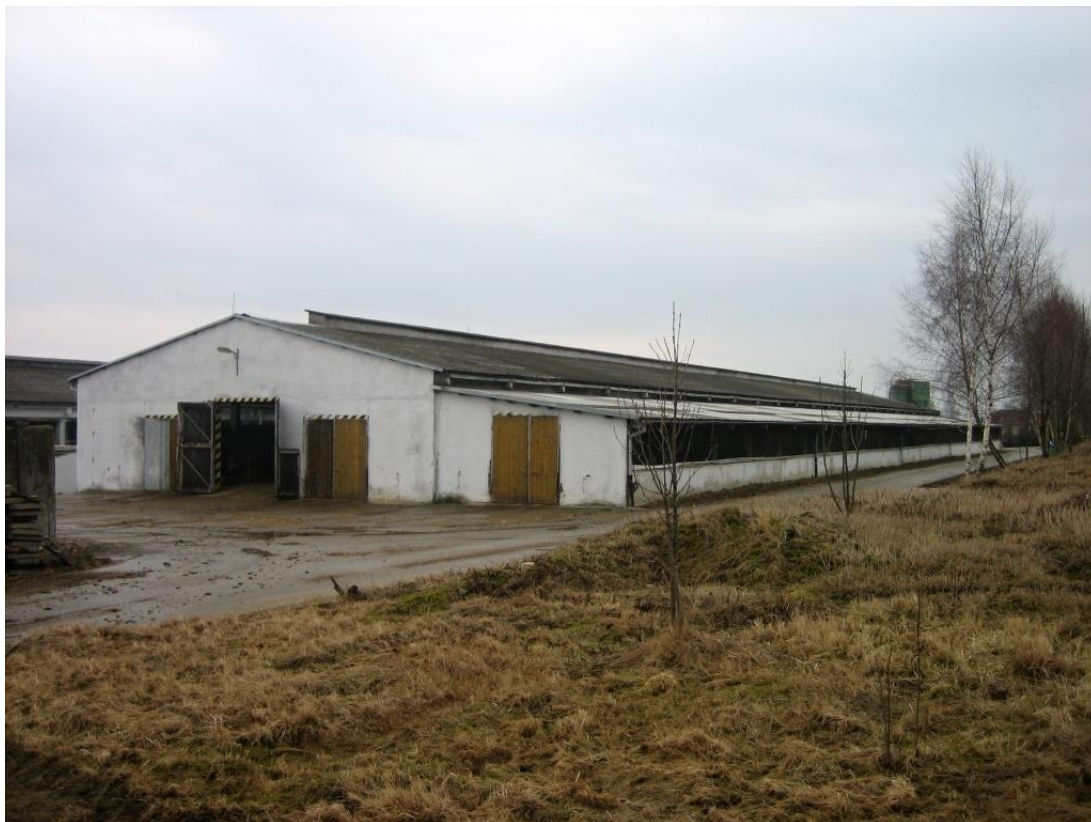
Obrázek 13. Pohled na halu 1 západně od silážní jámy
