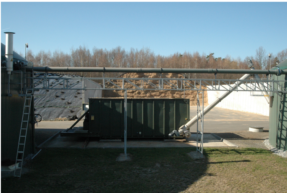
Obr. č. 9: Dávkovacími zařízení na pevné substráty BPS Třeboň pohled z boku (Zdroj: Zajíc, 2012)
