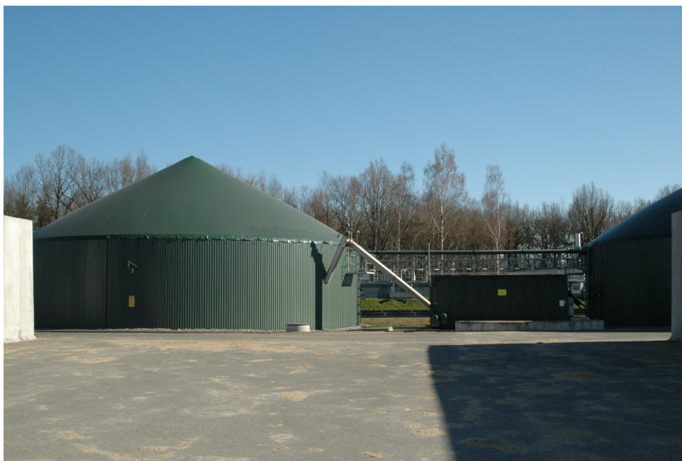
Obr. č. 8: Fermentor BPS Třeboň s dávkovacím zařízením (Zdroj: Zajíc, 2012)
