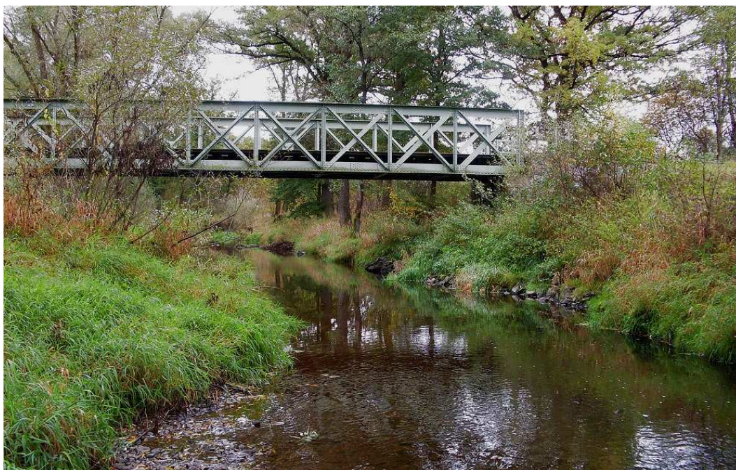
Obr. 28 - Železniční most – jediný propustek v náspu uzavírajícím širokou říční nivu. (Foto: Čampulka, 2011)
