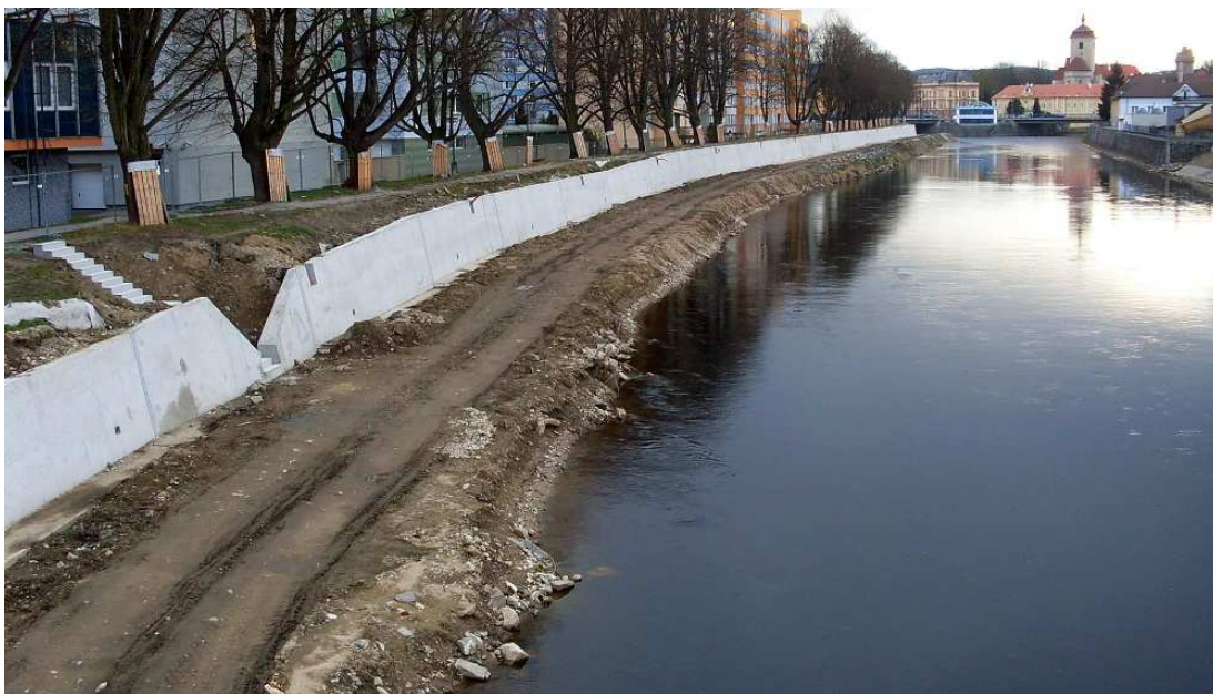
Obr. 30 - Úprava koryta toku Otavy pomocí železobetonové hráze ve Strakonících (foto: Čampulka, 2012)
