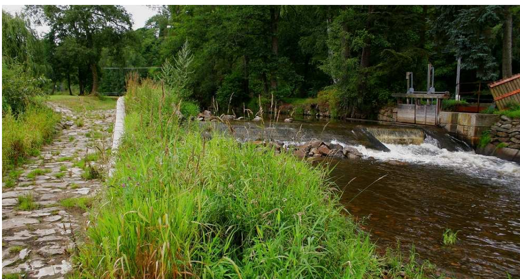
Obr. 24 – Jez v úseku BL022, pod jezem jsou antropogenně umístěné kameny omezující erozi (Foto: Čampulka, 2011)
