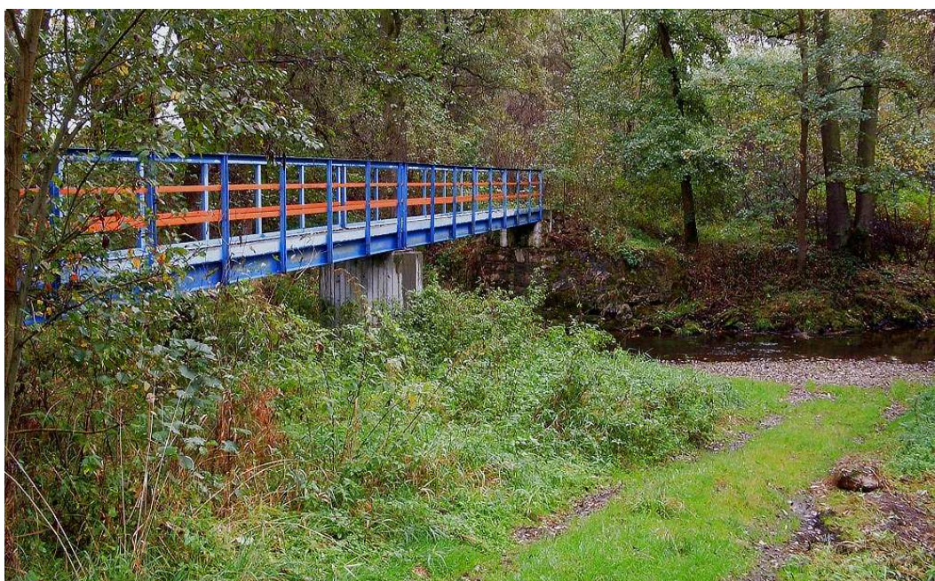
Obr. 29 – Lávka nevhodně umístěná 50 metrů před železničním mostem (Foto: Čampulka, 2011)
