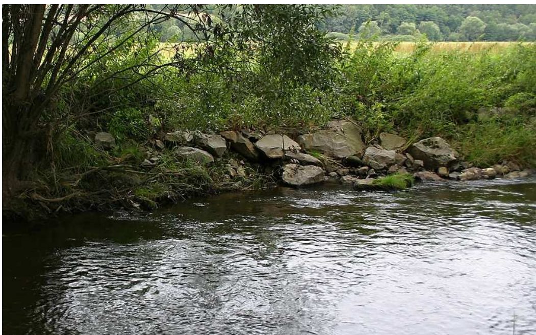
Obr. 15 – Lomovým kamenem zasypaná břehová nátrž (BL017 z MP_3_Blanička) (Foto: Čampulka, 2011)
