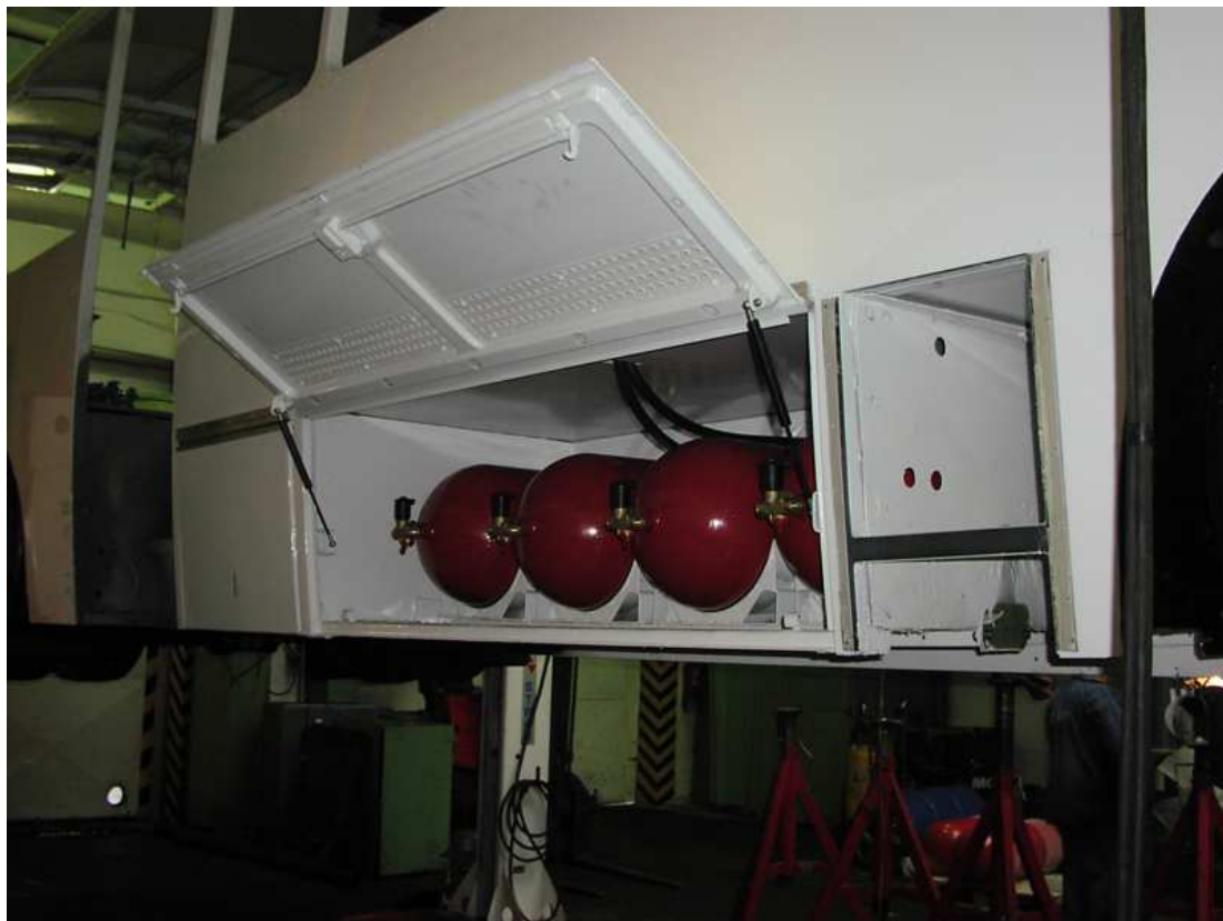
Obr.č. 11.1 Pohled na umístění tlakových nádrží CNG při přestavbě autobusu firmou ZLINER
