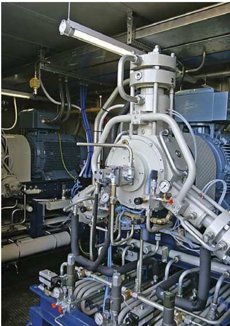
Obr. 9.6 Třístupňový kompresor švýcarské výrobce GREENFIELD používaný ve veřejných plnicích stanicích společnosti Gascontrol s.r.o.
