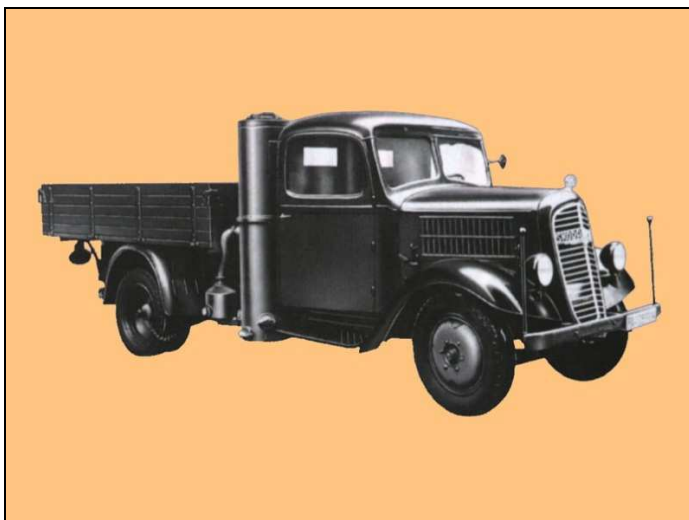
Obr. 5.6 Nákladní automobil vybavený kotlem na dřevoplyn (výrobce Dokogen, dnešní Atmos)
