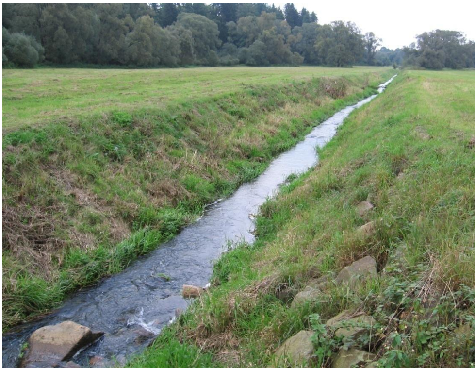
Foto č. 1 Zregulované koryto Stropnice pod Novými Hrady (lokalita Štiptoň)
