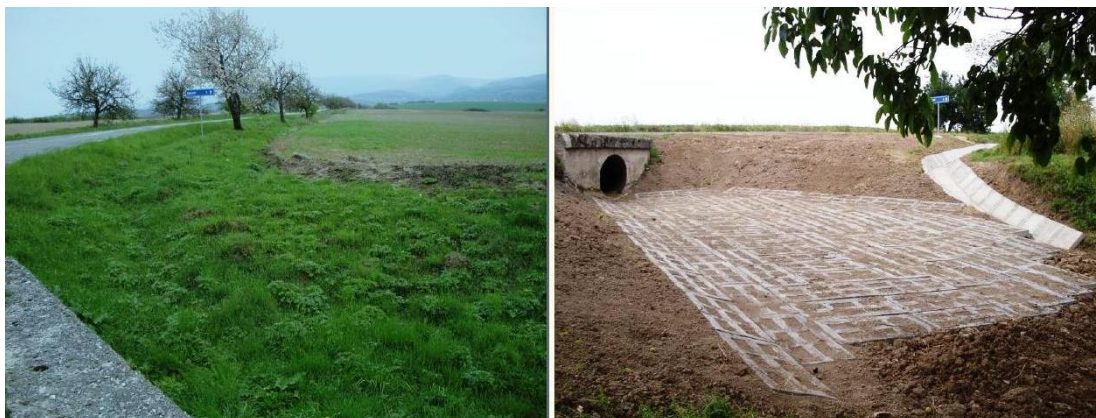
Obr. 8: Nižná Kamenica – výstavba svodné příkopky (Muchová, Konc, 2010)
