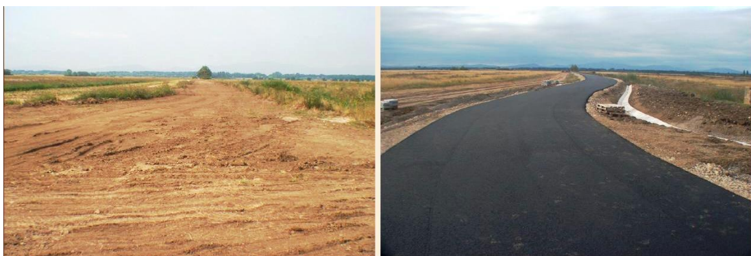
Obr. 9: Falkušovce – výstavba polní cesty (Muchová, Konc, 2010)
