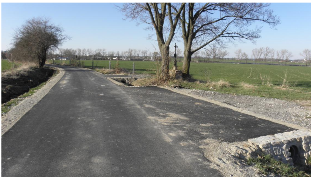
Obrázek 10 – P3 ve směru k obci Dynín – fotografie komunikace a sjezdů na pozemky
