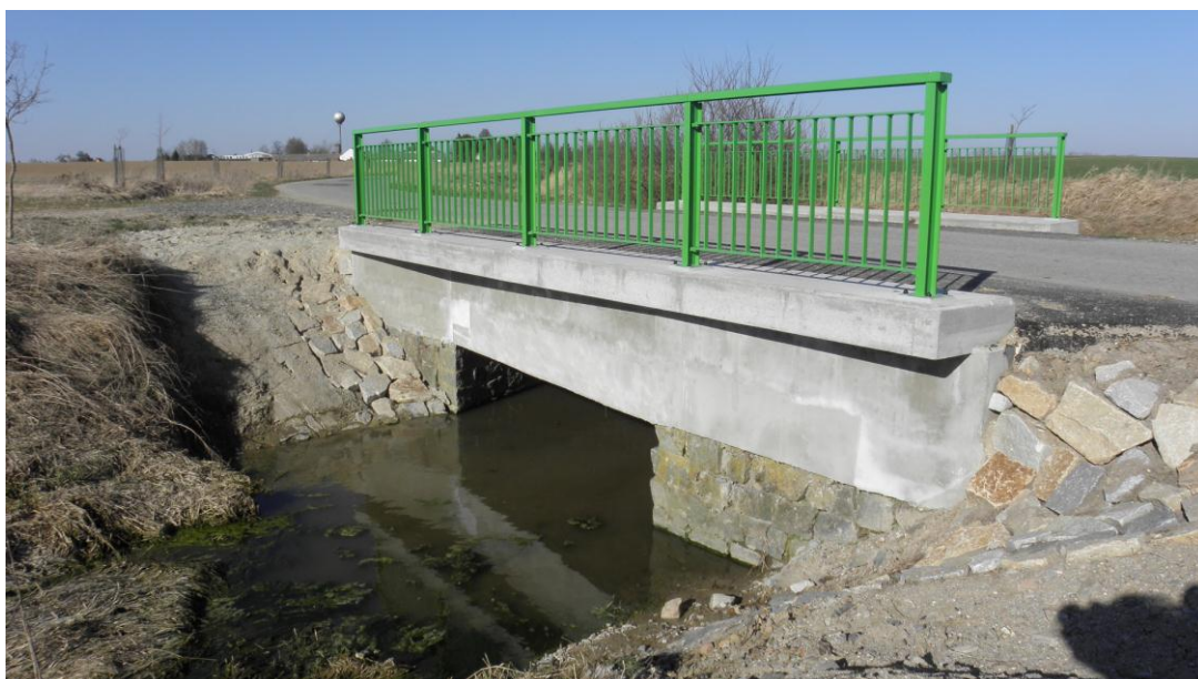
Obrázek 15 – zrekonstruovaná mostní konstrukce na úseku hlavní polní cesty P5
