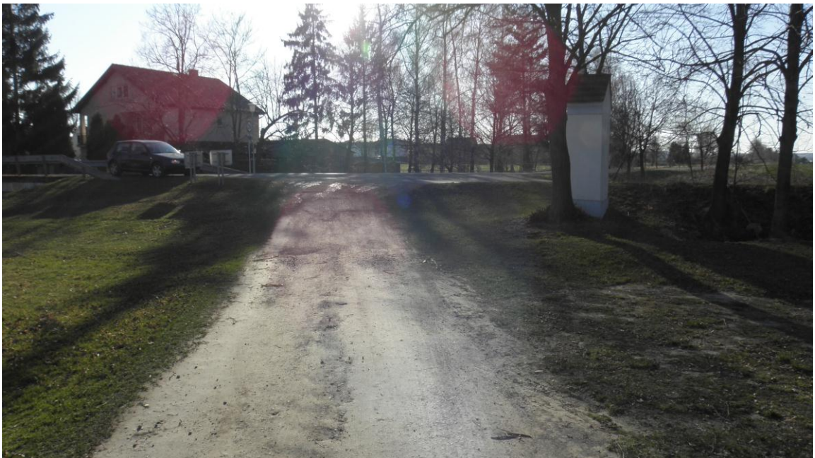
Obrázek 17 – sjezd z pozemní komunikace III. třídy na vedlejší polní cestu Pv5
