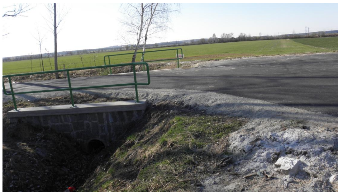
Obrázek 9 – P1 zrekonstruovaná mostní konstrukce
