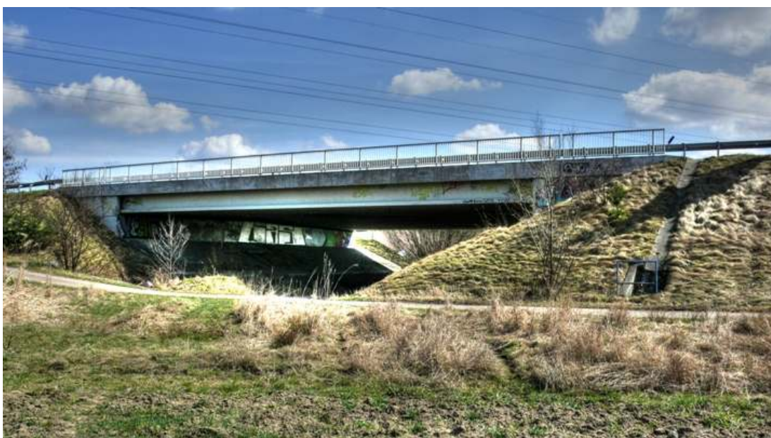
Snímek 4 : Most, pod kterým je plánováno vedení cyklostezky
