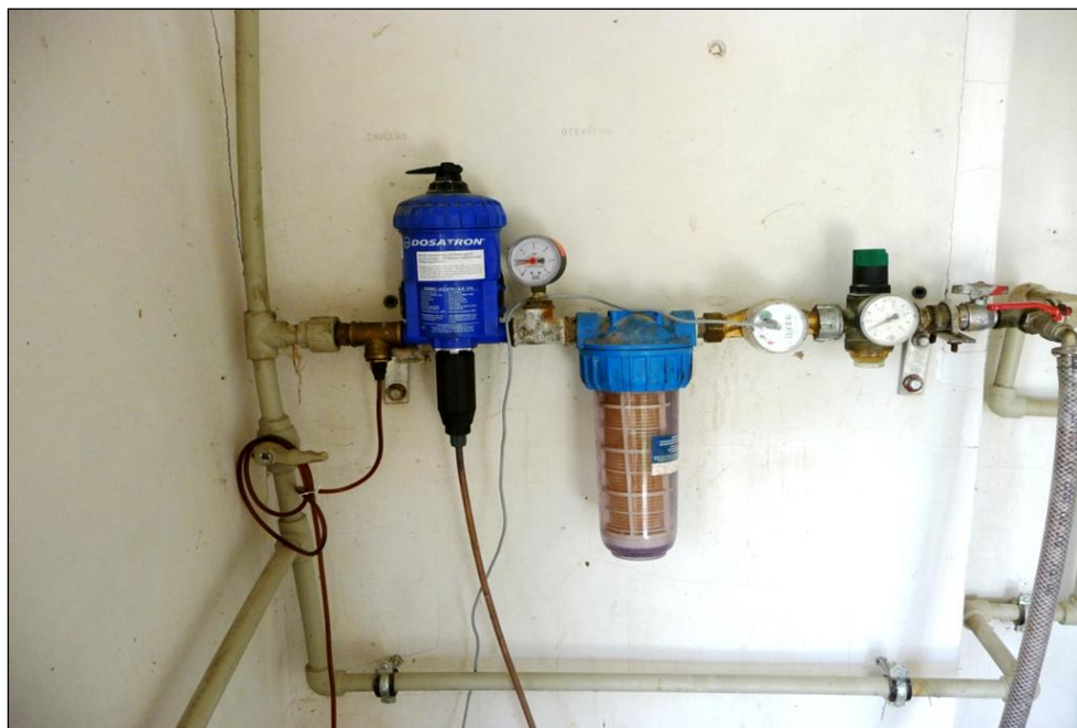
Obr. č. 6 – Zobrazení řešení napájecího systému, ve kterém je pitná voda (z komunálního řadu) kontinuálně – ve stanovené koncentraci – saturována bioalginátovým přípravkem.
