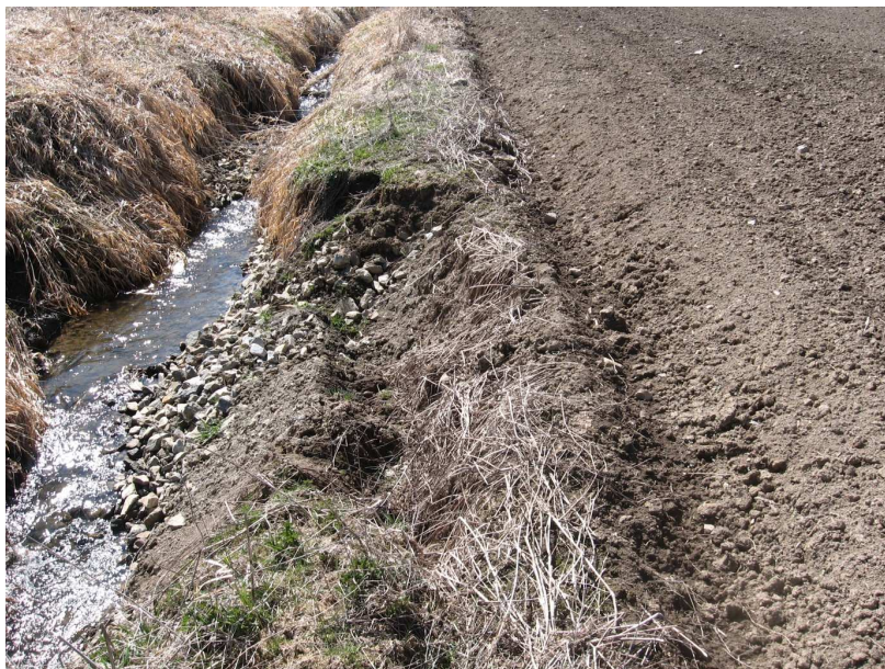
Příloha č. 10: Koryto Mirkovického potoka II.
