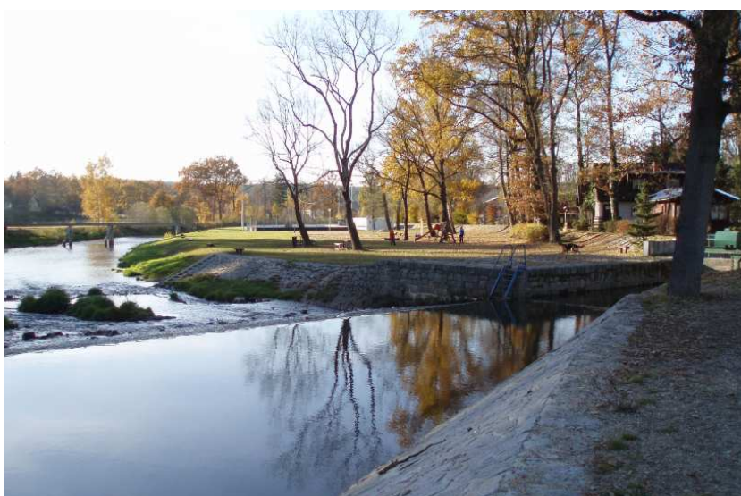
Obr. č. 5 Jez na řece Malši, zdroj: autor
