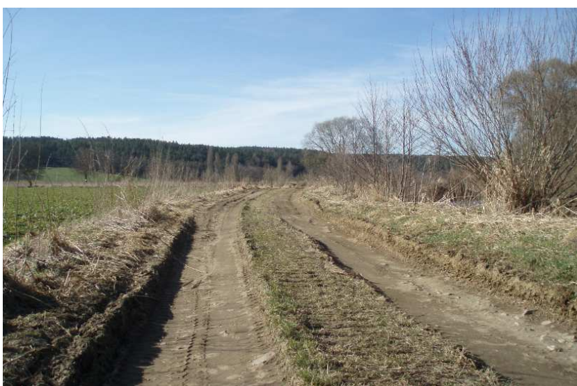
Obr. č. 11 Současný stav polní cesty, zdroj: autor
