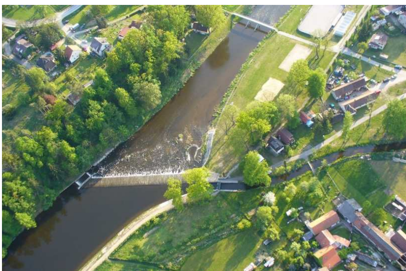
Obr. č. 2 Pohled na jez na řece Malší a Mlýnskou stoku, zdroj: www.ze-vzduchu.cz
