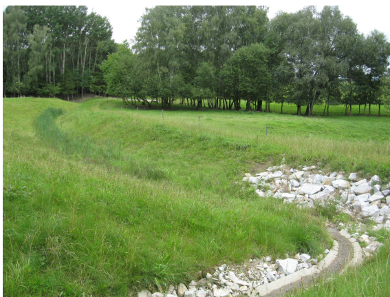
Foto č. 6: Protipovodňový kanál v západní části k.ú.
