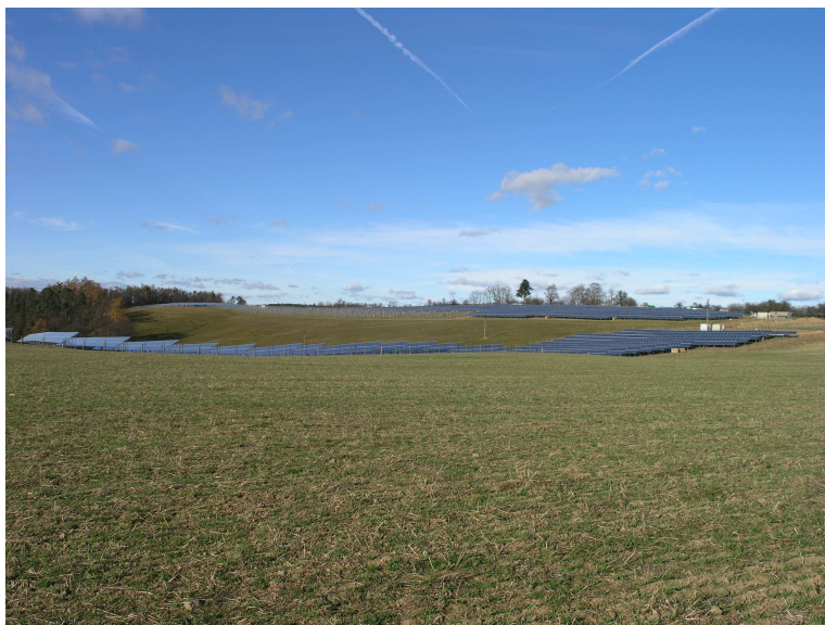
Fotografie 10: Fotovoltaická elektrárna - „Na Buchánu“ (Zdroj: Autor)
