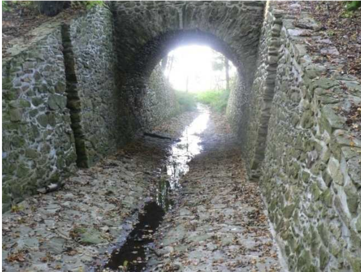
Rekonstruovaný most pod polní cestou C32, autor Hana Dvořáková
