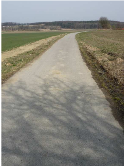
Foto č. 11: 13c – účelová komunikace rekonstruovaná
