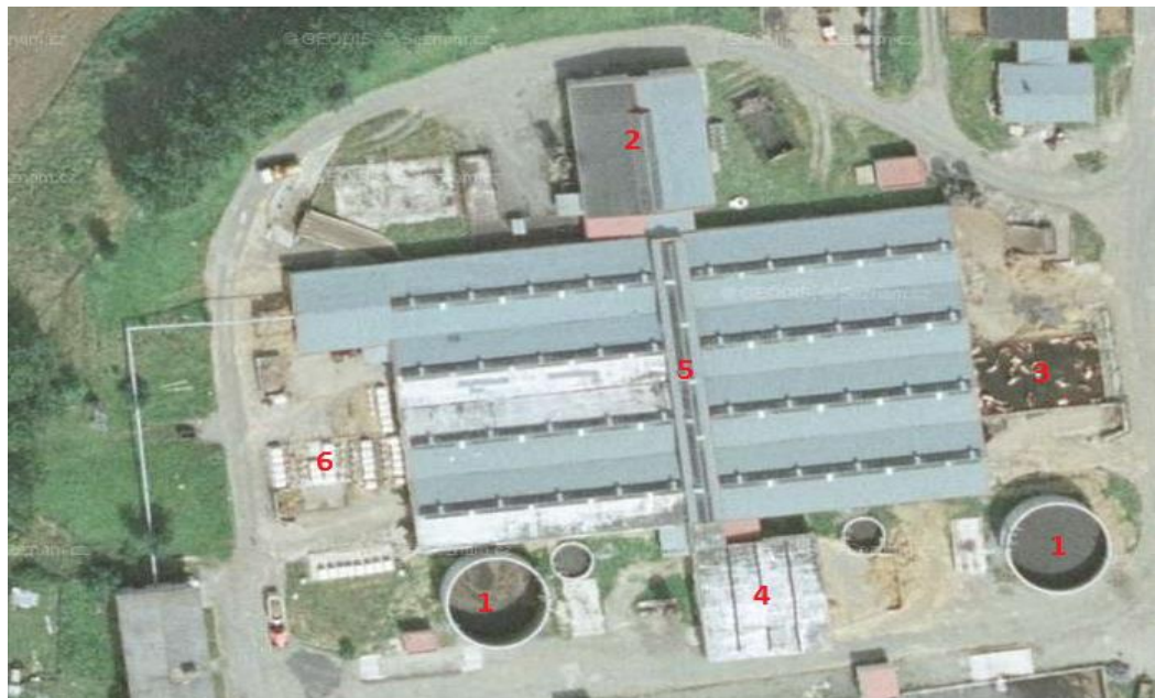
Obrázek č.10 - Fotografie VKK Tedražice v 2008 po částečné rekonstrukci
