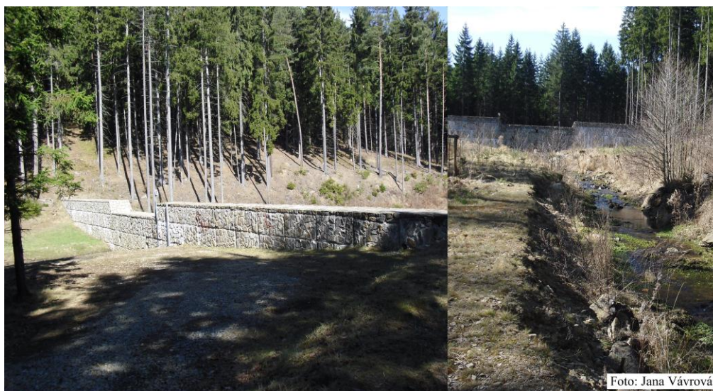
Obr. č. 5: Kamenná přehrážka na Libotyňském potoce
