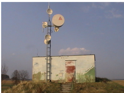
Obr. č. 23 – vodárna
