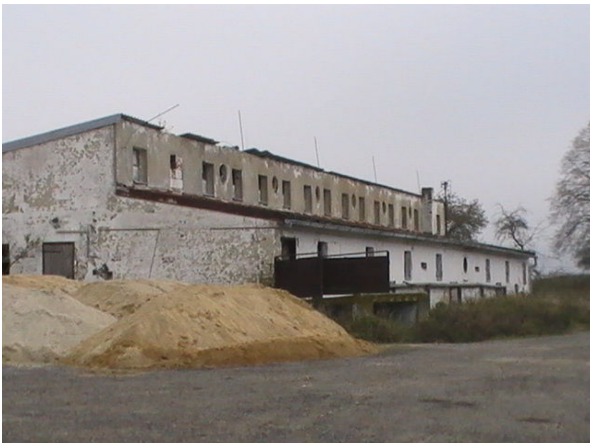
Obr. č. 25 – bývalý zemědělské areál
