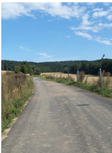
Příloha č. 23: Výstavba HPC 1 v k.ú. Prasetín
