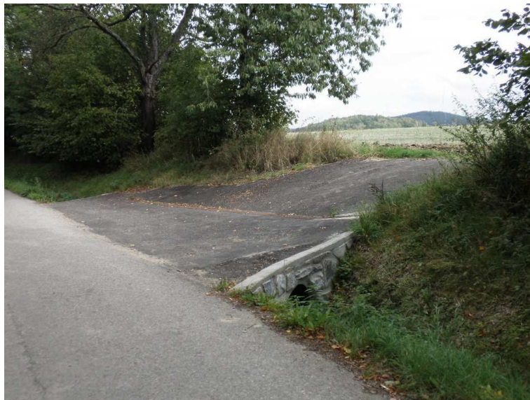
Obr. č. 13: Nově zrekonstruovaný propustek a vjezd na pole
