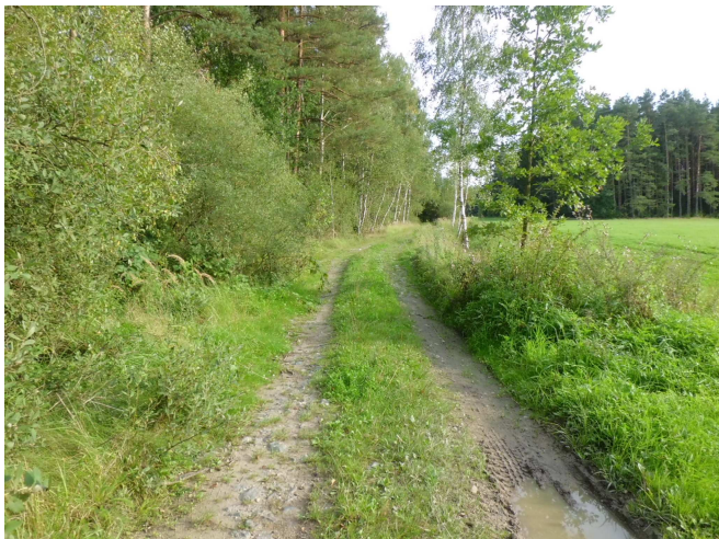
Foto 3: VPC s kolejovou úpravou vozovky (k.ú. Borkovice)
