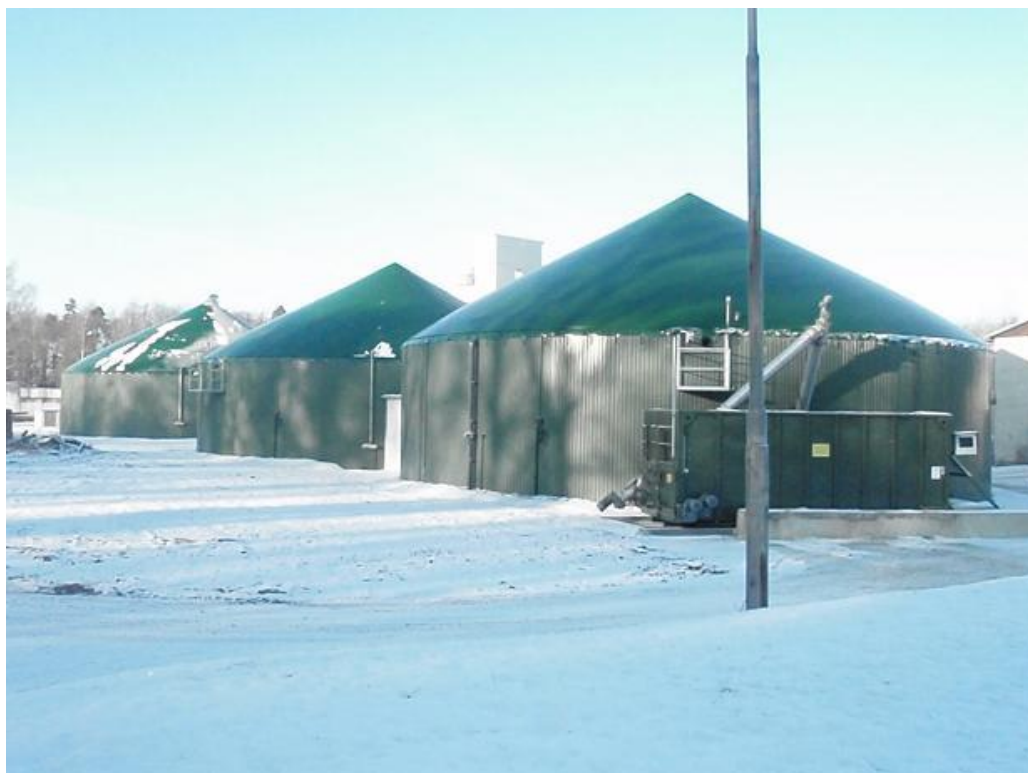
Obrázek č. 6: Fermentory bioplynové stanice v Třeboni, zdroj: E.ON
