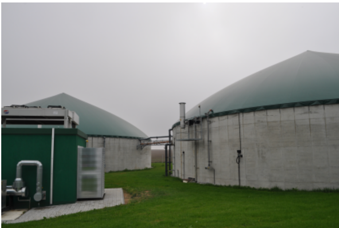
Obr. 16– Skladovací nádrž na fermentační zbytek – digestát (Zdroj: foto Wollner, 2011)
