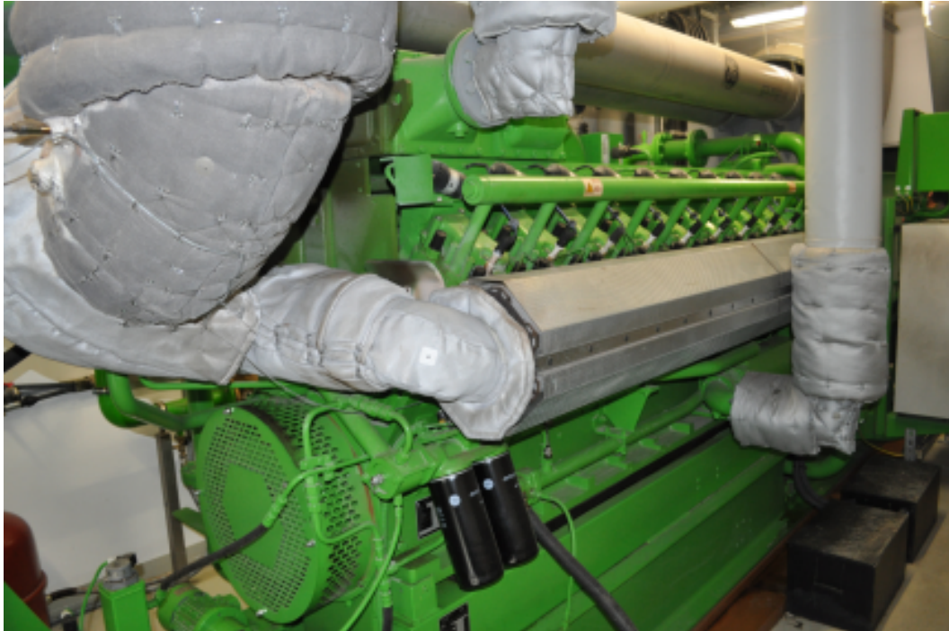
Obr. 14 – Kogenerační jednotka (Zdroj: foto Wollner, 2011)
