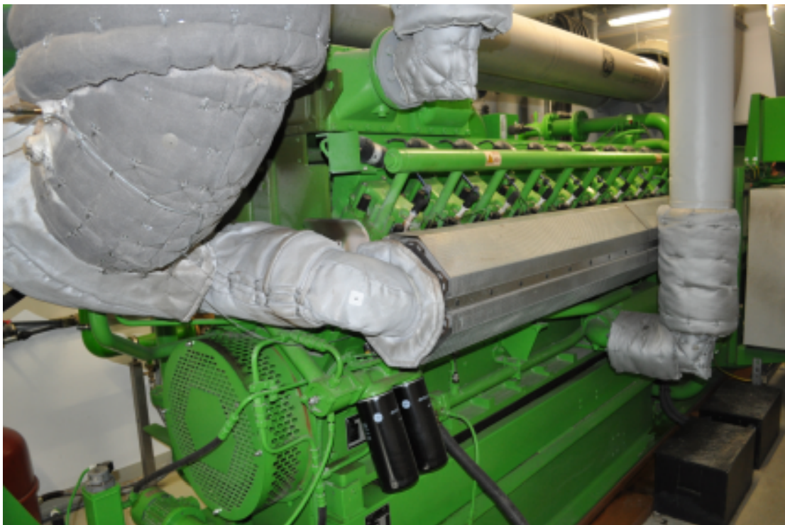
Příloha č. 6 – Kogenerační jednotka BPS 5 (Zdroj: foto Wollner, 2011)
