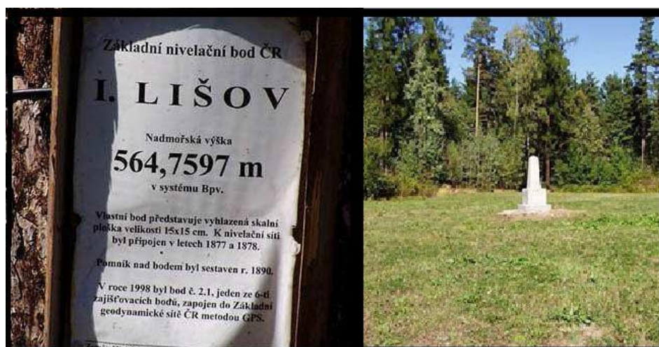
Obr. 5 Základní nivelační bod Lišov, zdroj [22]
