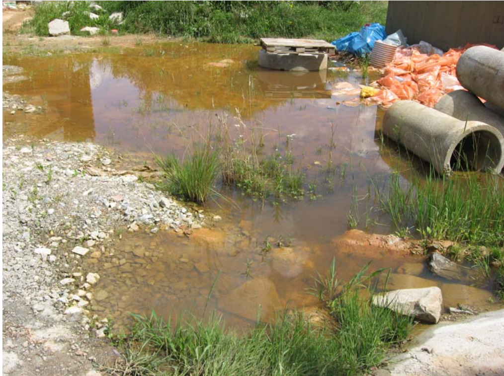
Foto. 15. Lokalita Třebín nová (TRE 09). Staveniště rodinného domu, louže po technických dtrojích a stavebním materiálu.
