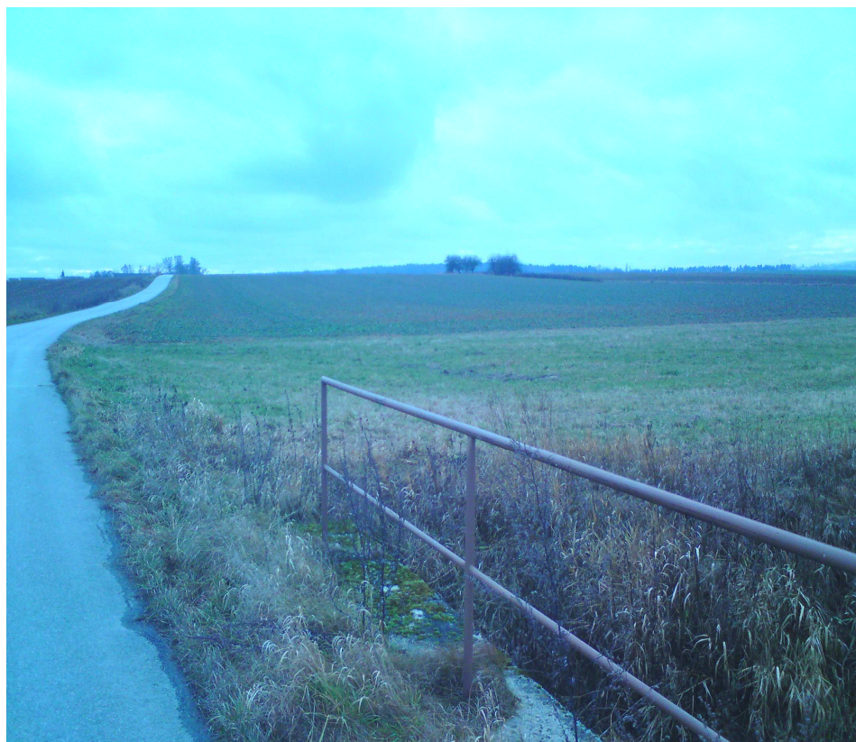
Obr.3.2 Pohled od severovýchodu, most přes Ponědrážský potok. (Dohnalová, Sony Ericsson)
