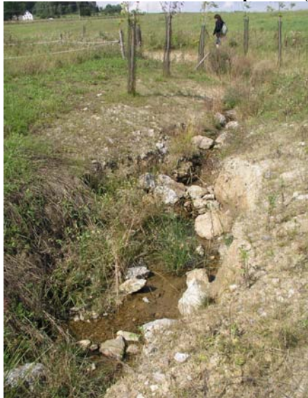
Obr. 5.11: Obnovené koryto Kleštínského potoka
