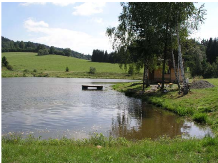
Obr. 5.8: Obnovený rybník U Pečenky
