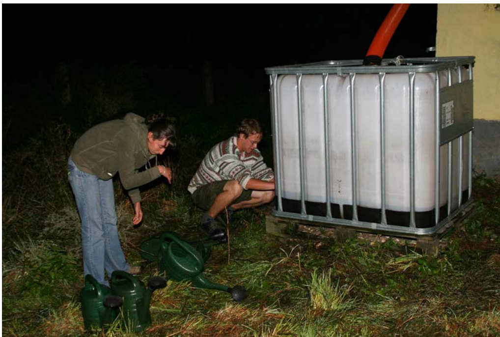
Obrázek 4: Cisterna na srážkovou vodu
