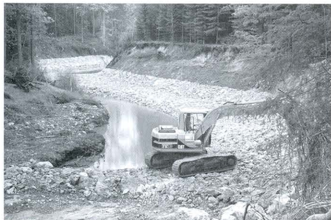
Sanace odtoku od bezpečnostního přelivu Rožmberka (foto autor)
