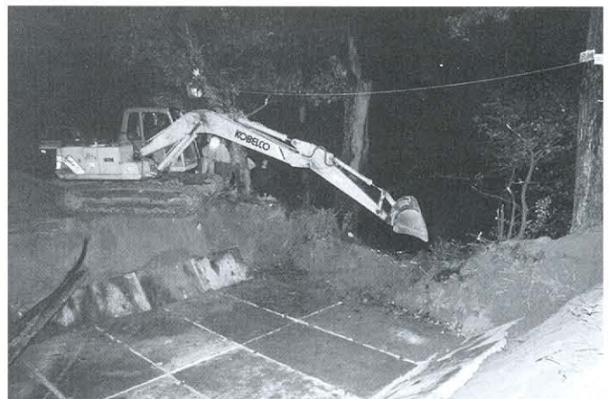
Budování havarijního přelivu na rybníku Svět, srpen 2002 (foto autor)
