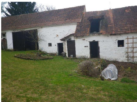
Obr. č. 6: Užitkové budovy.
