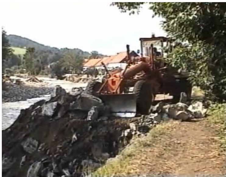
Obrázek 45 Grejdr rozhrnující zeminu při opravách koryta řeky [20]
