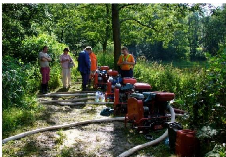
Obrázek 52 Přečerpávání vody pomocí hasičské techniky [36]
