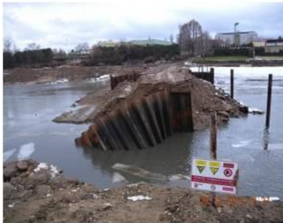
Obrázek 7 Protržení hráze rybníku Jordán v Táboře [7]
