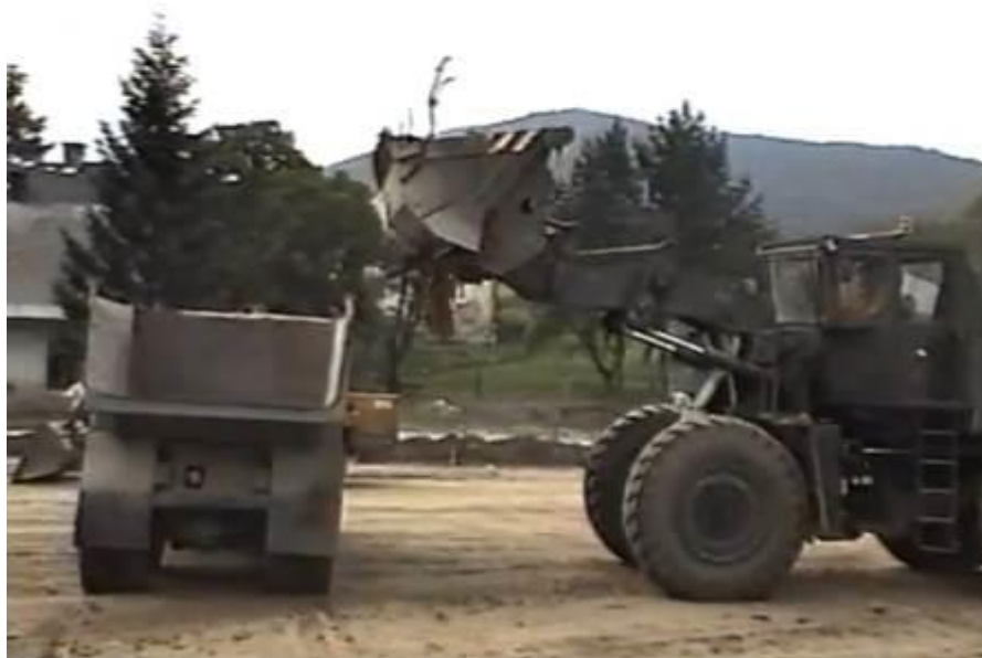
Obrázek 22 Kolový nakladač nakládající naplaveniny pomocí víceúčelové lopaty [20]
