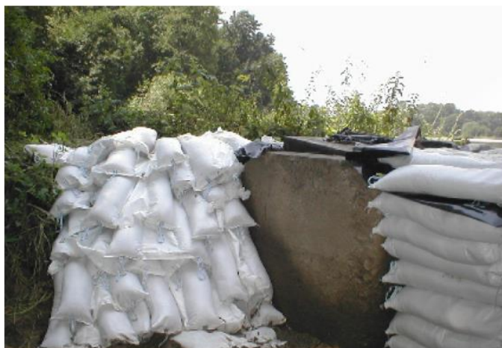
Obrázek 53 Sanace poškozené hráze provedená pytlí s pískem [36]
