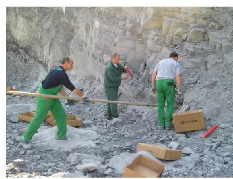
Obrázek 30 – Nabíjení patních vrtů (6)
