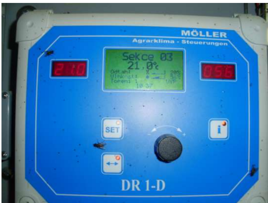
Obrázek 9 – panel s obrazovkou pro kontrolu parametrů pro každou místnost
