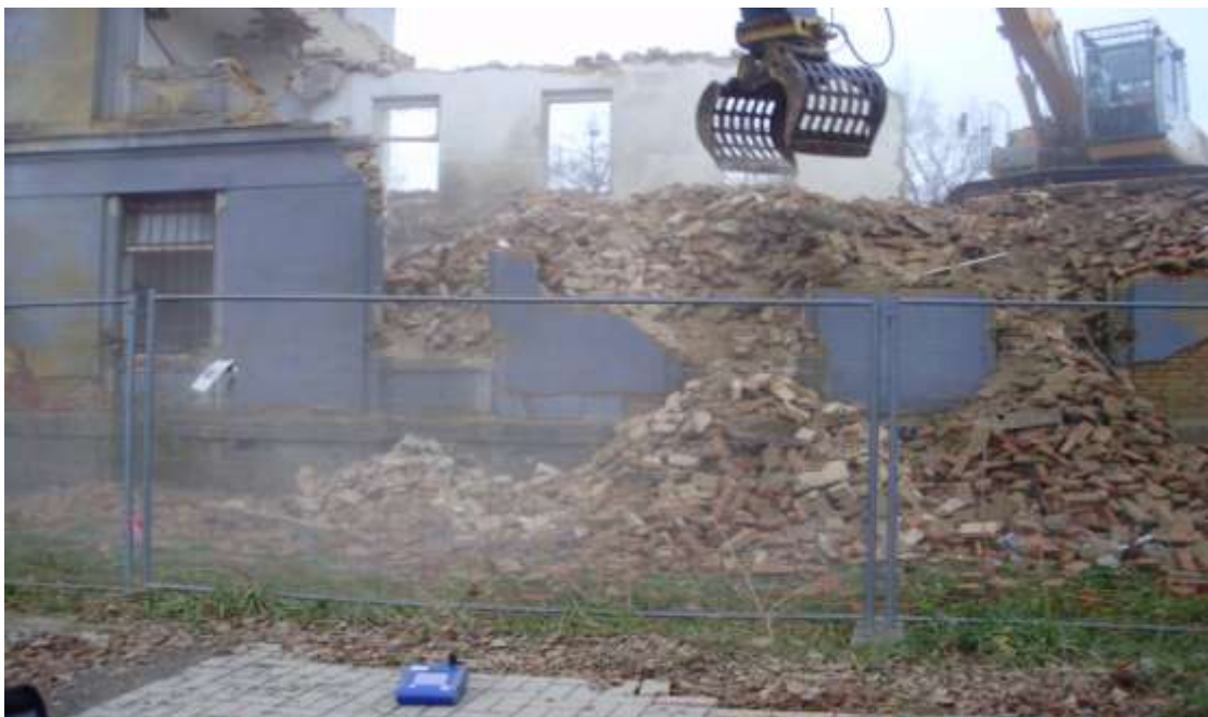
Obrázek 33 – situace pro provalení boční stěny
