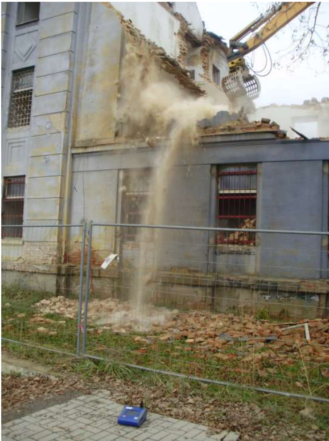
Obrázek 28 – stržení stěny a vznik prachu
