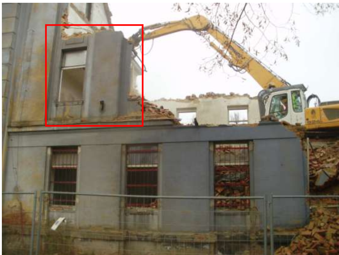
Obrázek 27 – pohled na demolovanou zeď
