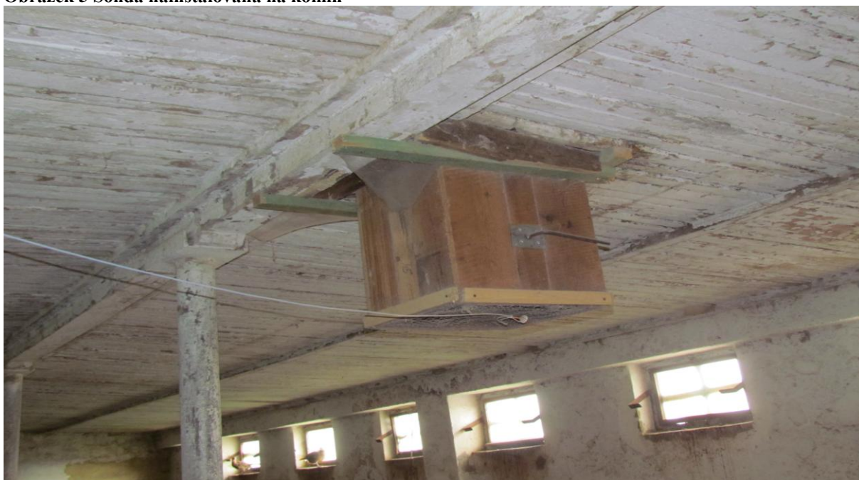
Obrázek 5 Sonda nainstalovaná na komín
