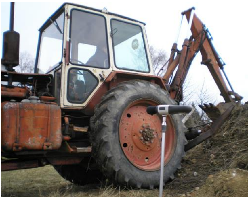
Obrázek 15 – Měření při nakládání zeminy
