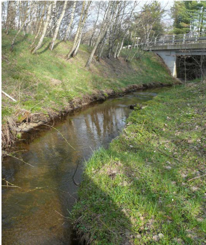
Obr.č.15: Přeložka Lomnického potoka
