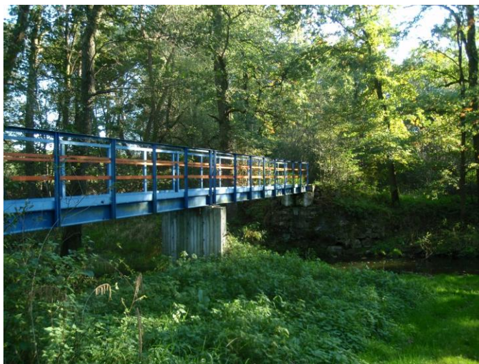
Obr. č. 195 Lávka přes Blanici (zdroj: vlastní)
