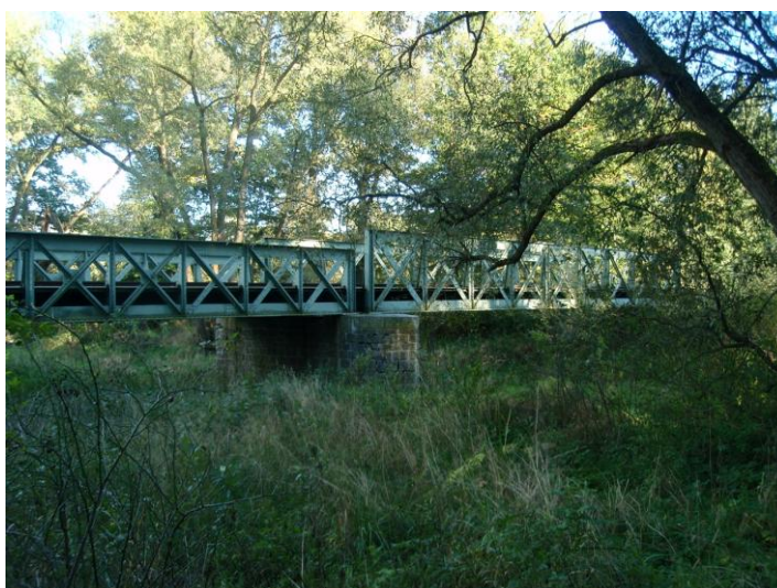
Obr. č. 206 Železniční most přes Blanici (zdroj: vlastní)
