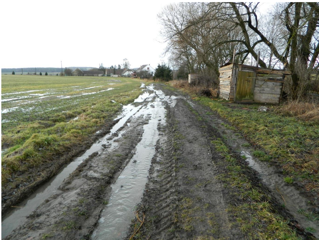
Obrázek 2 Nevhodně řešená úcelová cesta C22, zdroj: autor
