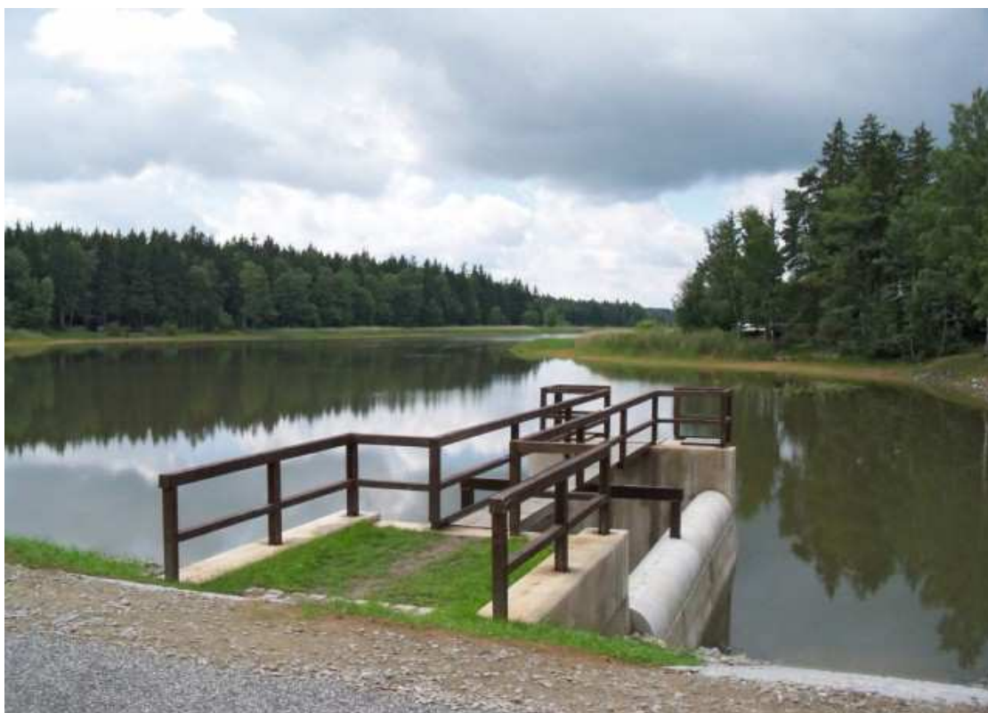
Obr. č. 6 – Pohled na funkční zařízení rybníka po rekonstrukci
