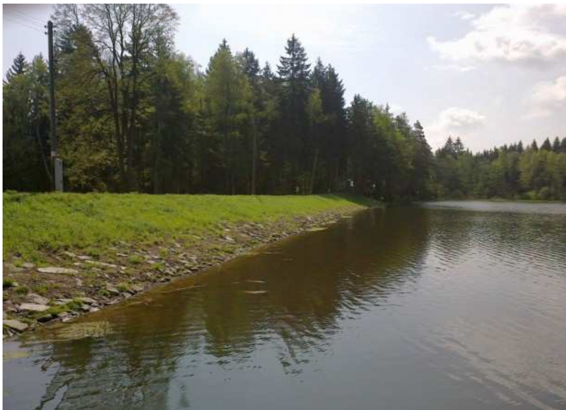
Obr. č. 5 – Pohled na hráz po rekonstrukci
