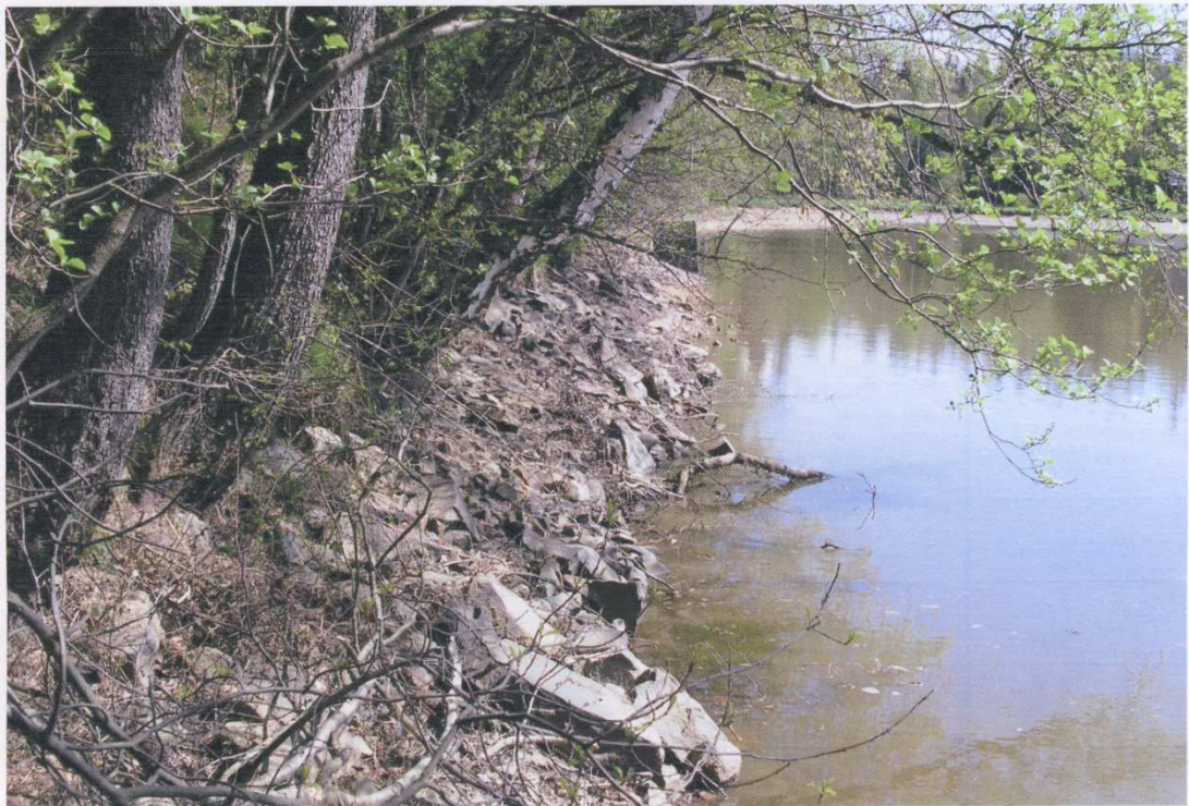
Obr. 4 - Pohled podél návodní strany hráze. V pozadí je druhý (nefunkční) požerák
