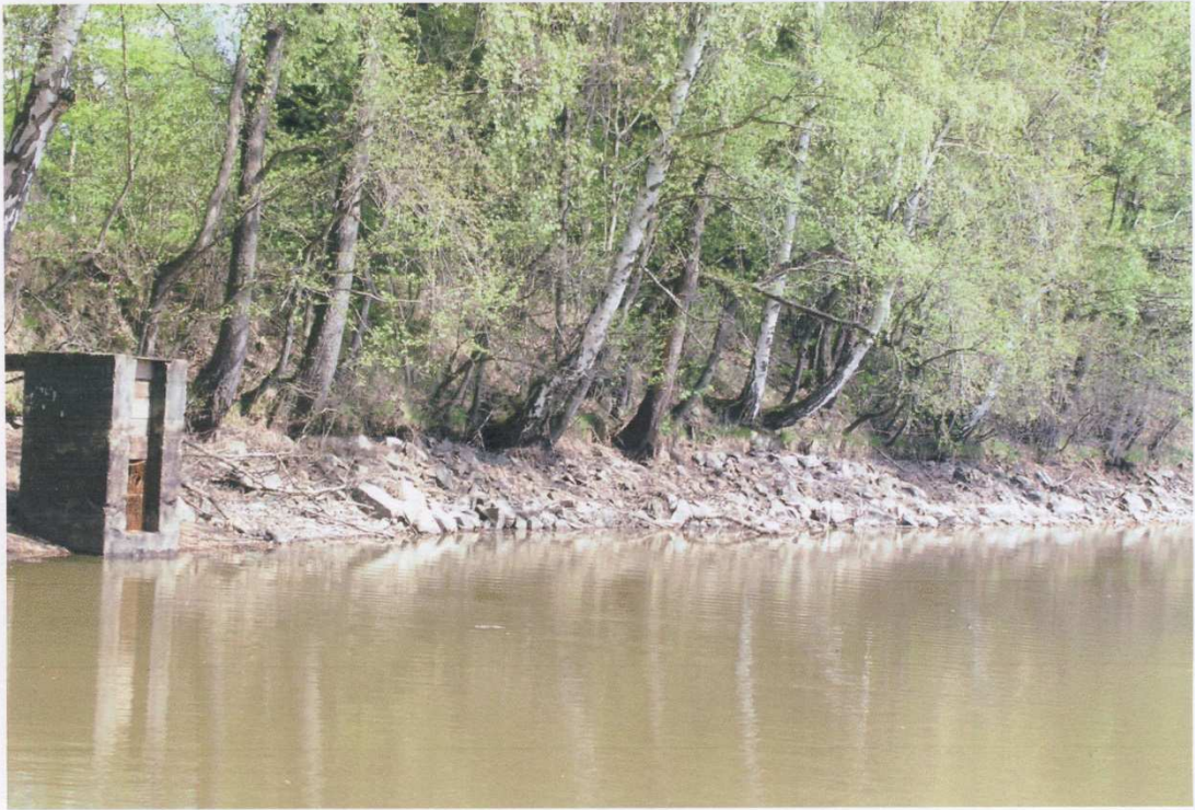
Obr. 3 - Pohled na funkční vypouštěcí zařízení (požerák) a na část hráze
