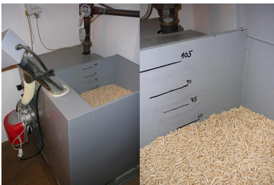
Obr. 32 Násypka na pelety s dopravním šnekem a detail vnitřní stěny s ryskami (foto: Petr Tomášek)
