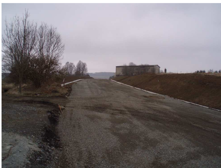
Foto č. 7 a foto č. 8 Stavba přeložky komunikace II/230
