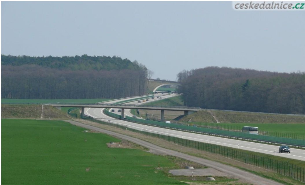
Obrázek 6: ekodukt, zdroj: http://foto.ceskedalnice.cz/nase-foto/objekt/ekodukt/d11-volec/slides/03.html
