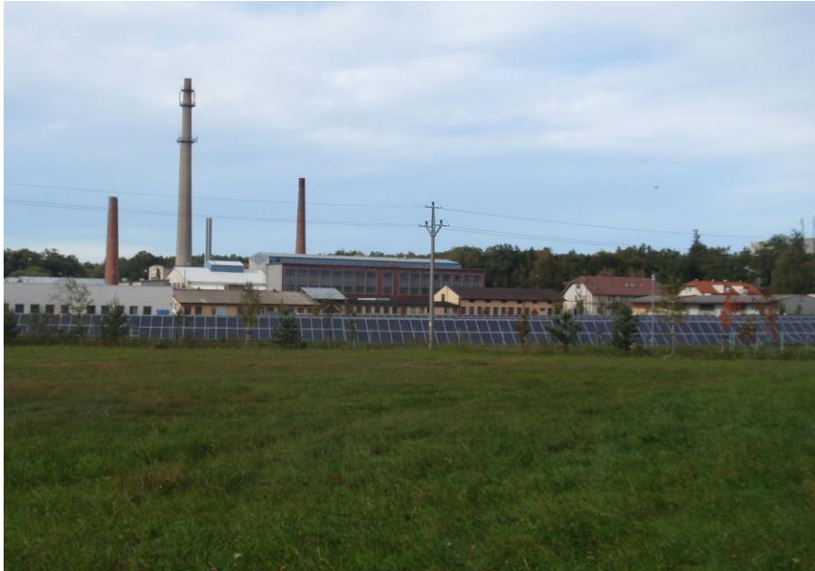
Obr. č. 8 Stavba FVE v Chlumu u Třeboně v současnosti (Zdroj: Milan Dušek)
