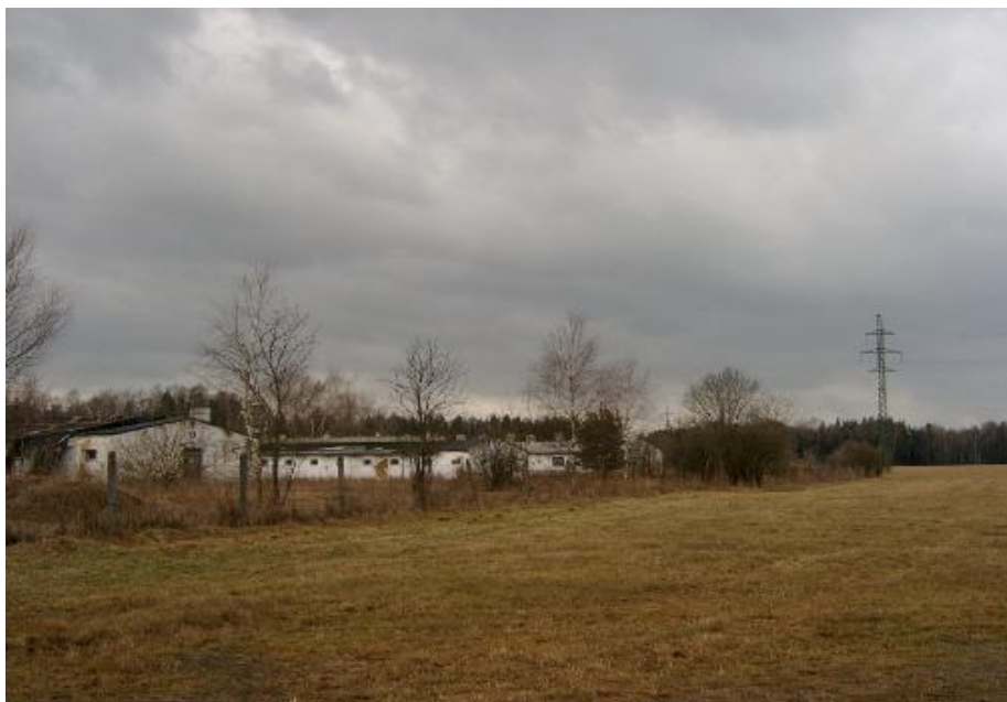
Obr. č. 3 Areál bývalého vepřína v Klikově, 2009 (Zdroj: AOPK ČR, SCHKO Třeboňsko)
