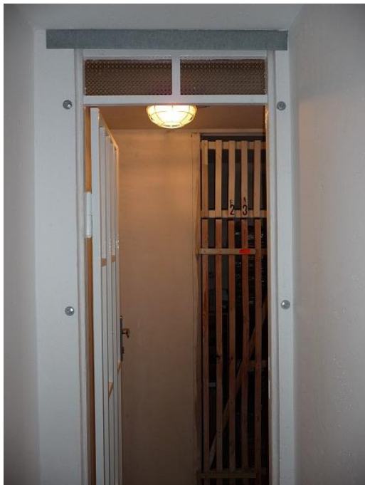
Obrázek č. – Byt č. 3: sklepní kóje
