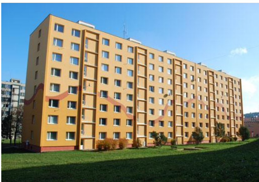
Obrázek č. – Byt č. 4: panelový dům s výtahem
