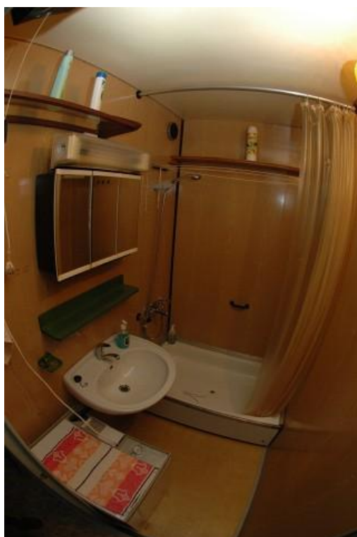
Obrázek č. 8 – Byt č. 4: umakartové jádro
