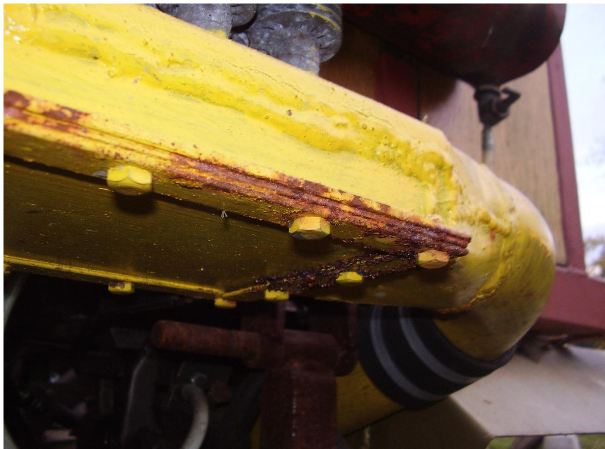
Obrázek 4.2 koroze spodní části chladiče
