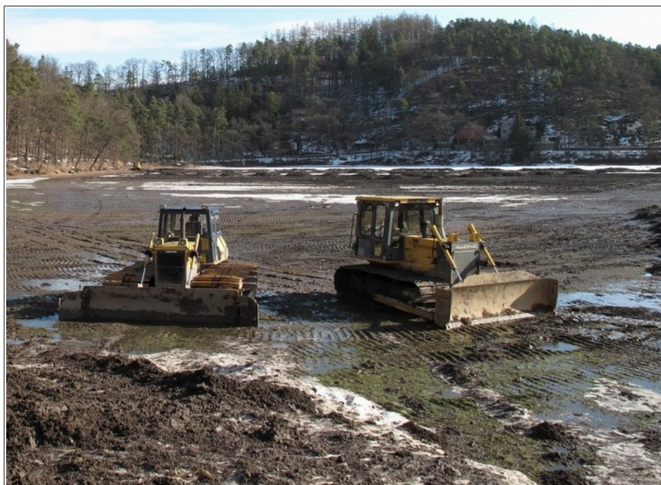
Obrázek 3 Vyhrnování usazenin z rybníků pomocí dvou dozerů [4]
