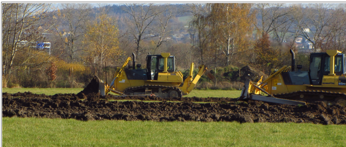
Obrázek 13 Práce strojů na staveništi Okružní ulice
