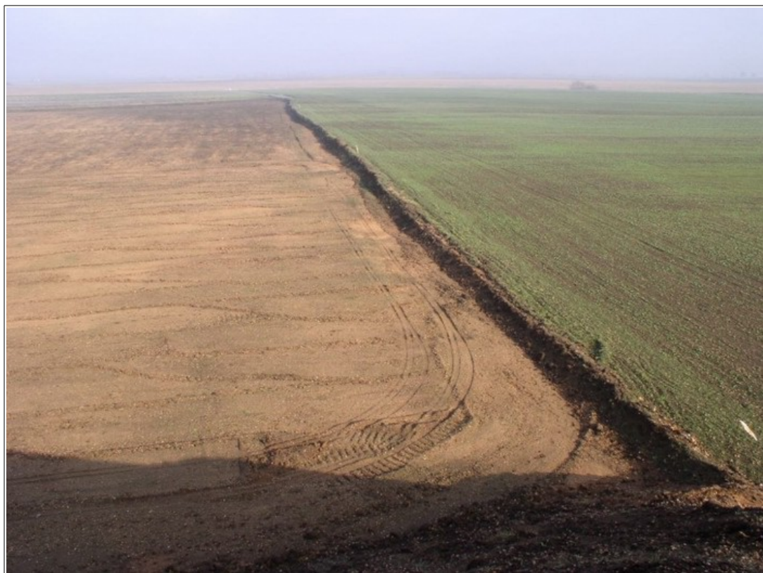
Obrázek 1 Výsledek technologie vykopávka s vodorovným přemístěním výkopu [1]
