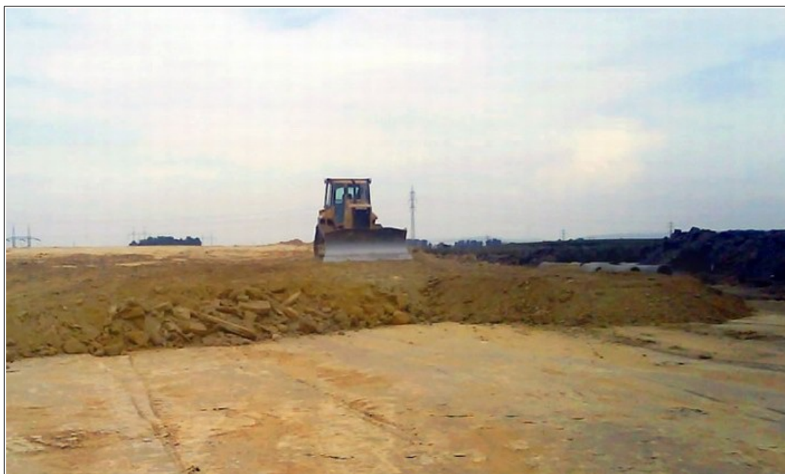
Obrázek 2 Rozhrnování horniny [3]
