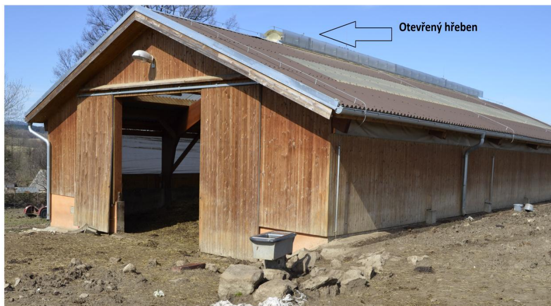
Obrázek 16: Větrání otevřeným hřebenem
