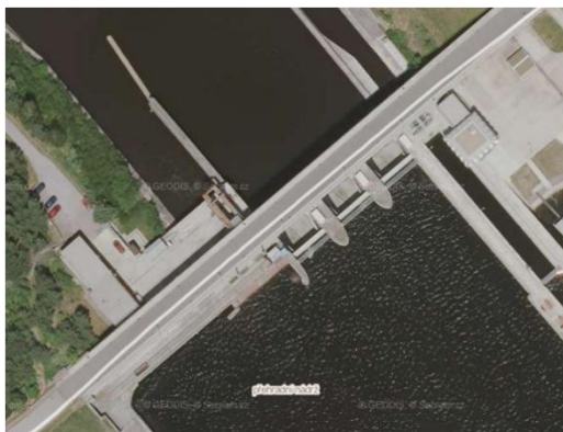
Obr. č. 3 Hněvkovická hráz
